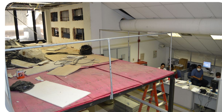
Funcionários trabalham em agências em reforma. É o caos
